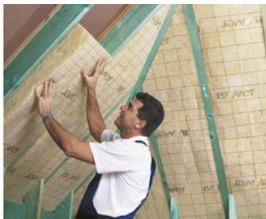
Plaatsing van dakisolatie met lambda-waarde 0,035 W/mK
