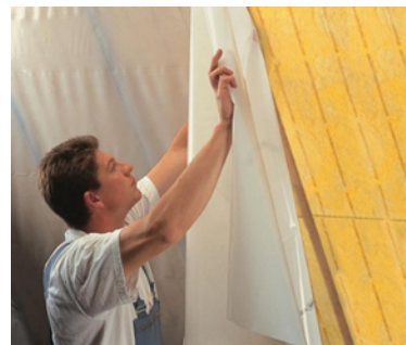
Aanbrengen van een dampscherm
