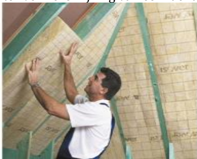
Plaatsing van dakisolatie met lambda-waarde 0,035 W/mK
