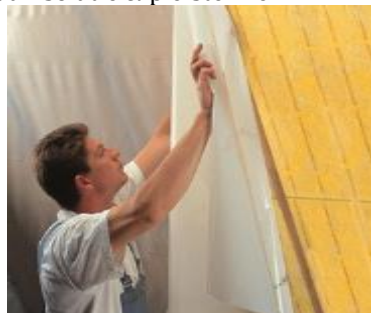
Aanbrengen van een dampscherm
